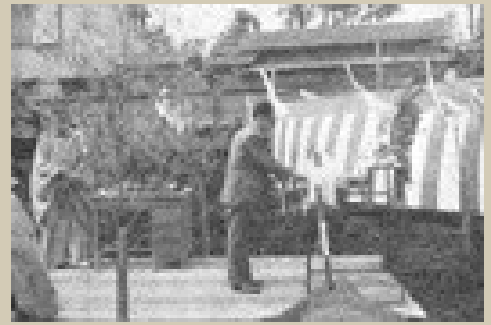
● 埼玉建設会館施工
