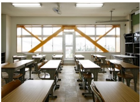
◀ 耐震補強工事 (小学校校舎)
