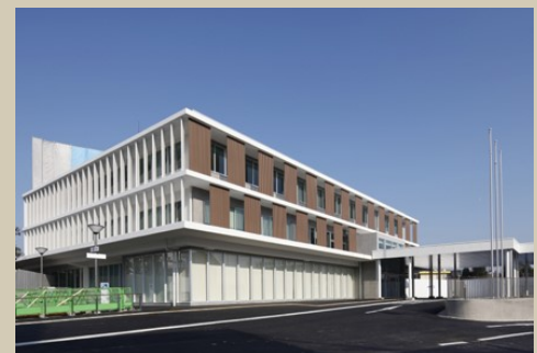
● ふじみ野市庁舎施工
