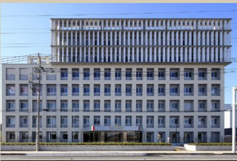
● 大宮警察署等統合庁舎施工
