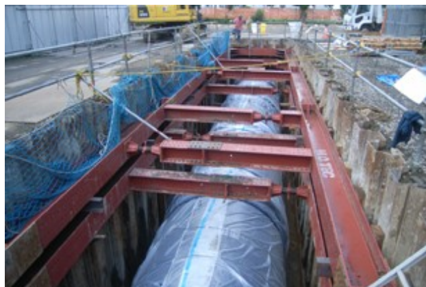
▲ 地下埋設物布設工事
