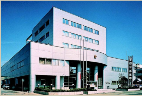
● 浦和警察署庁舎施工
