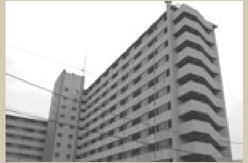
● 県営与野高層住宅施工 (竹中工務店とJVを組み、県内初の鉄骨鉄筋コンクリート造)
