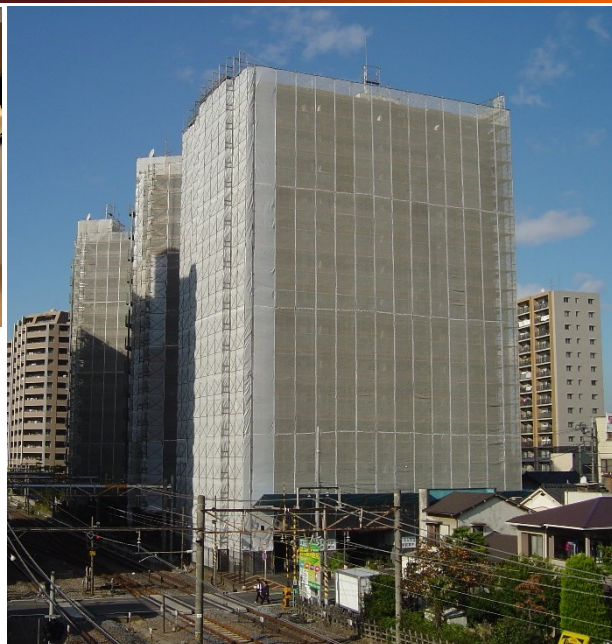
▲ 外壁・屋上防水工事 (マンション)
