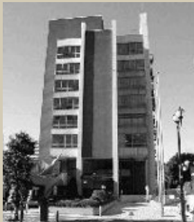
● 浦和市民会館施工
